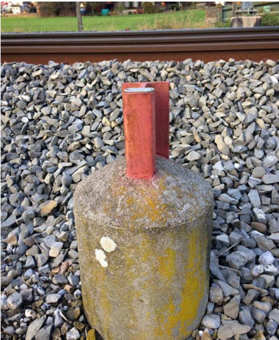
Bauliche Hindernisse entlang von Bahnstrecken (wie Gleisversicherungspunkte, im Bild) sollen so weit wie möglich entfernt werden.
