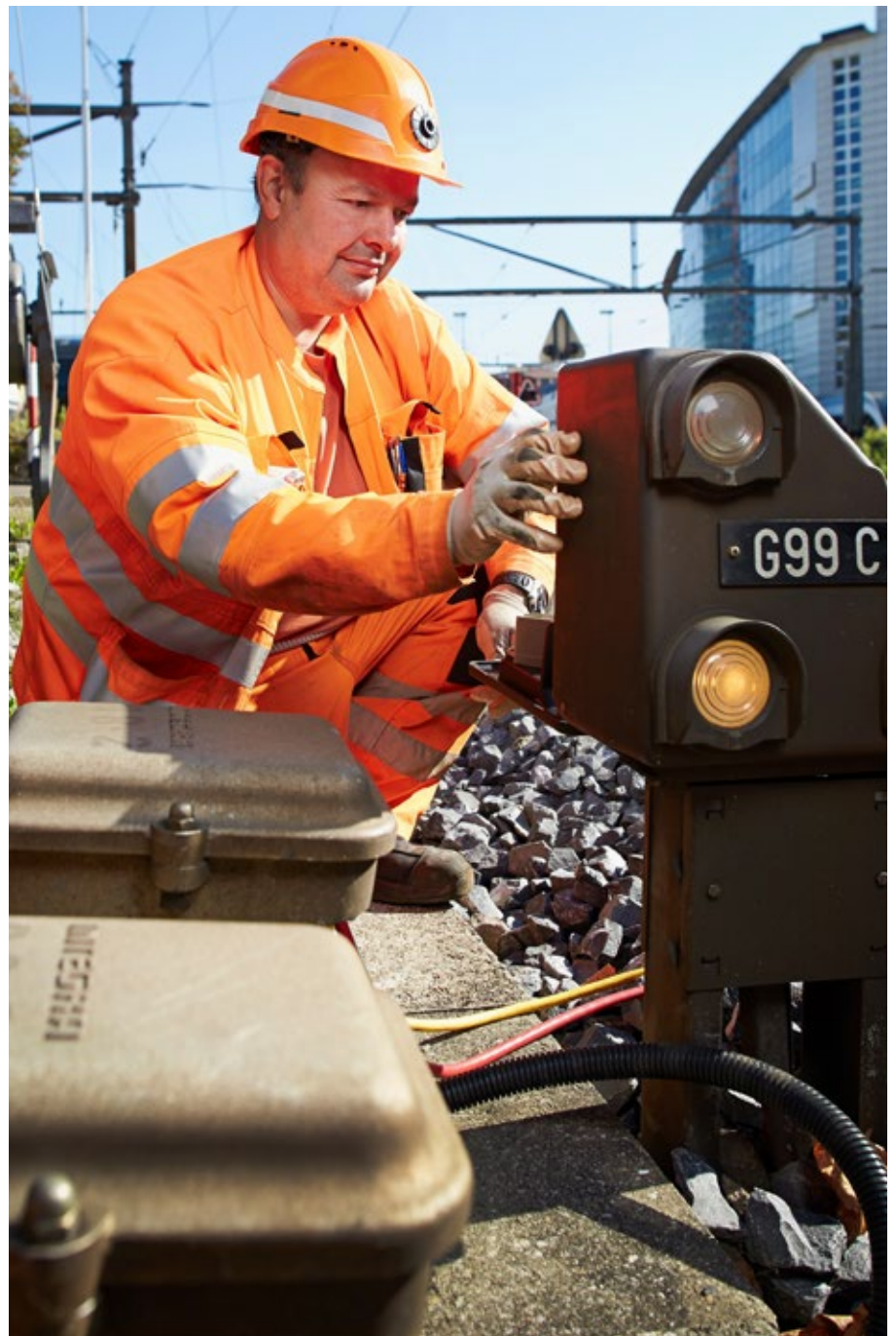
Die SUVA hat eine Broschüre zur Arbeitssicherheit im Gleisbereich veröffentlicht.
