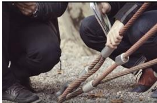
Abbildung 12: Jährliche Hauptinspektion beinhaltet Freilegen der Fundamente
