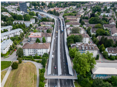
Ostring mit neuen Lärmschutzwänden
