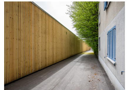
Lärmschutzwände seitens Wohnhäuser
