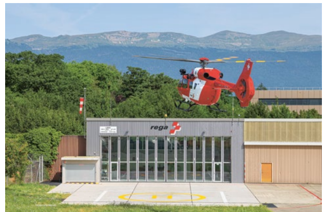
Bild ganz oben: Neue Einsatzbasis in Mollis (GL). Bild rechts: Hangar der Basis Mollis in moderner Holzbauweise. Bild links: Modernisierte Basis Genf.
